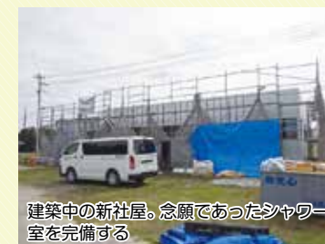
建築中の新社屋。念願であったシャワー室を完備する
