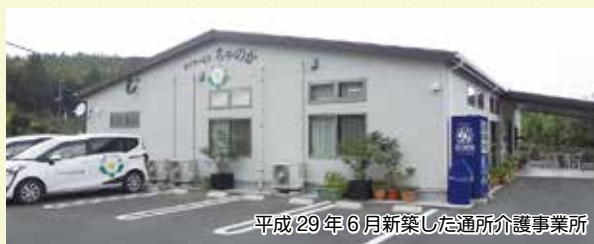
事業所隣接地に老人ホームを新築
