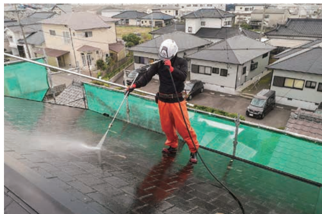
▲全品当社支給の装備品を装着し、細部まで規程された安全施工マニュアルに基づき、高圧洗浄作業を行う当社職人
